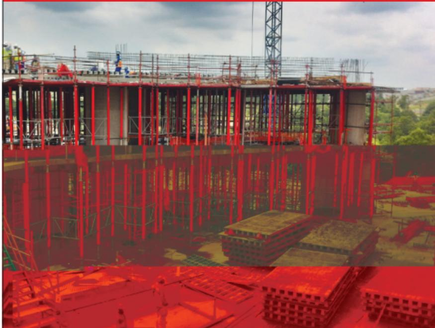
El sistema Alu-Up de Form Scaff es la mejor alternativa para losas altas, entregando resistencia y altura, pero de bajo peso en sus componentes. Está hecho de aluminio, combinando gran capacidad de carga y altura, pero bajo peso propio.
